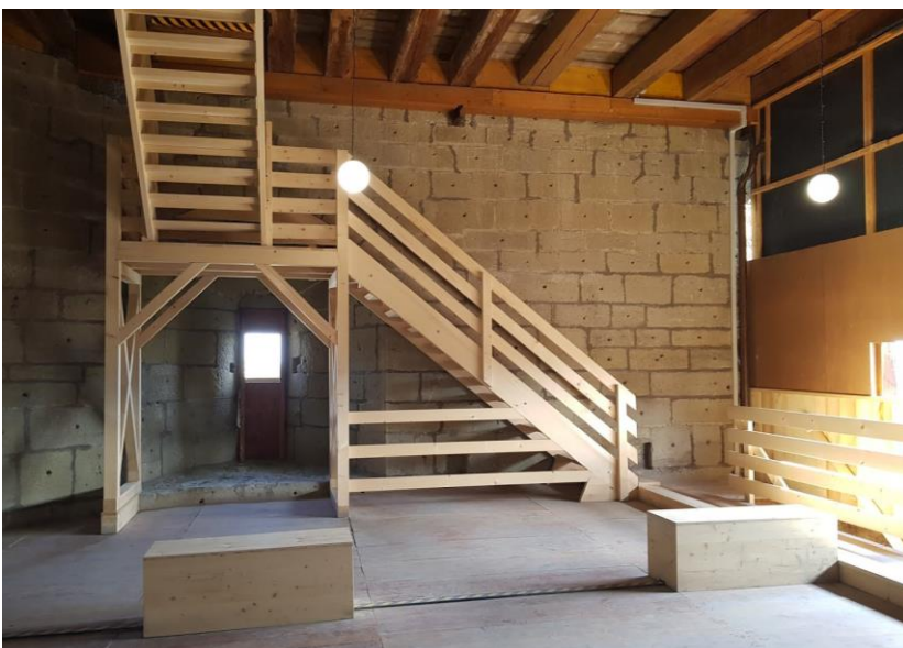
Escaliers et garde-corps
