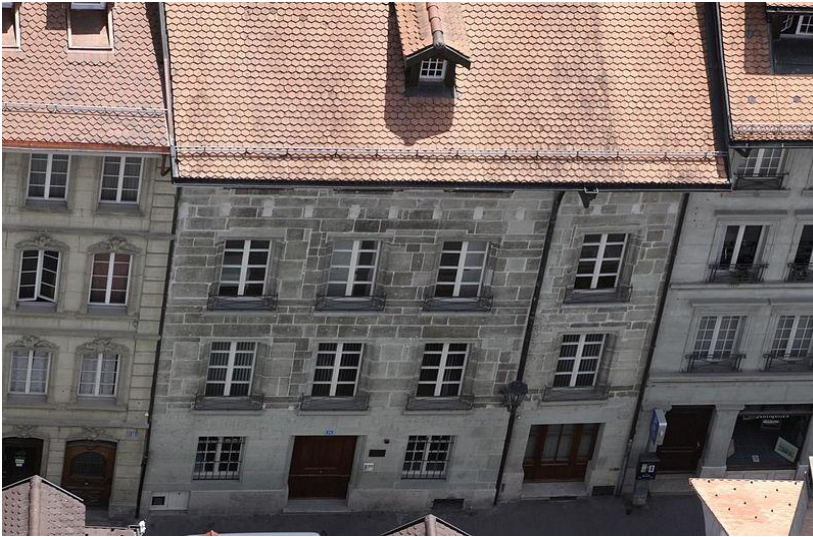
Maison de Reyff de Cugy - Grand-Rue 14
