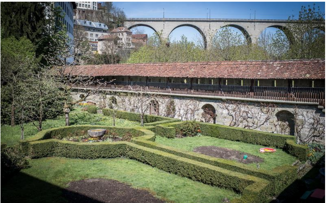
Vue de l'intérieure de la ville. Accès depuis propriété privée
