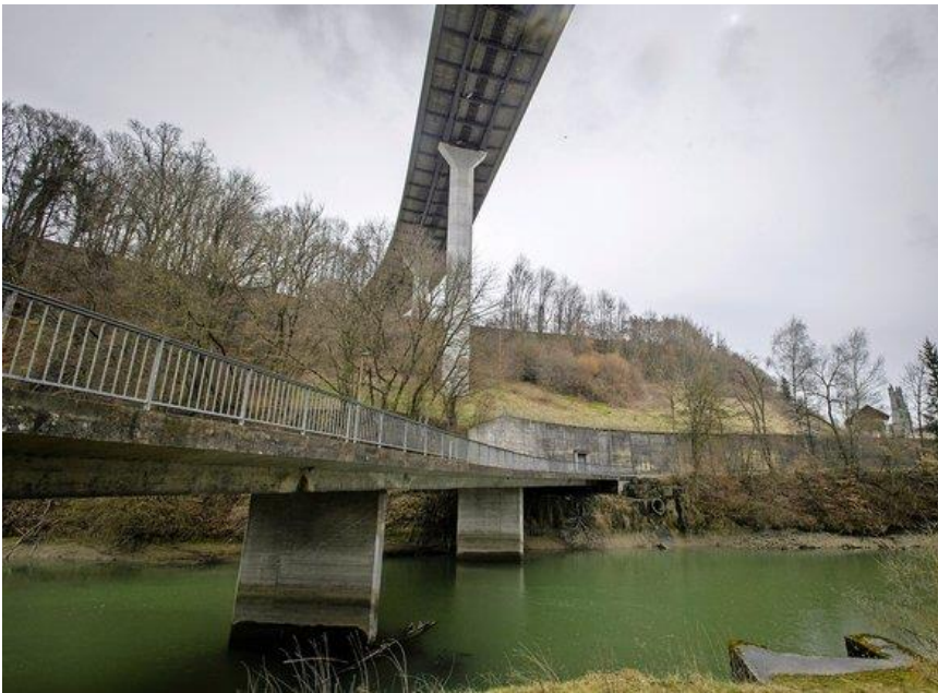
Au-dessus, le Pont de la Poya
