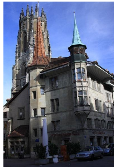
Maison de Gottrau, dite Les Tornalettes - Grand-Rue 67
