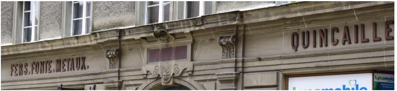
Rue du Pont Suspendu (Ancienne quincaillerie Wassmer)
